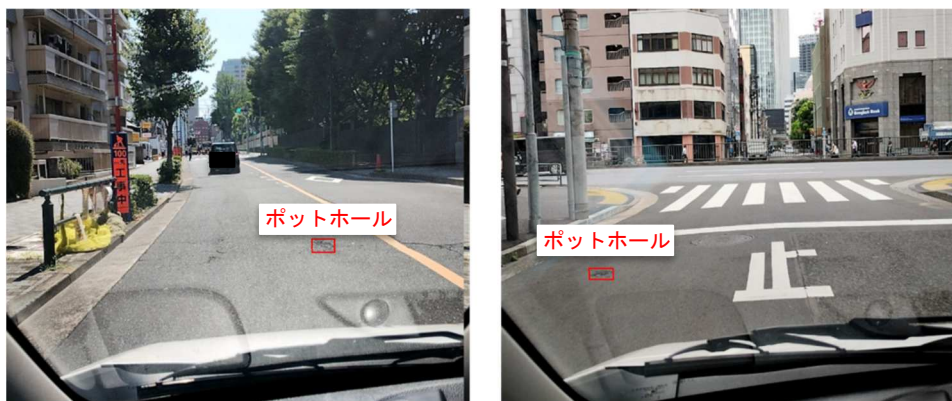
街路で検知された損傷事例（ポットホール）
