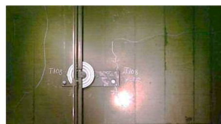
高解像度カメラ画像 (東急田園都市線トンネル内)
